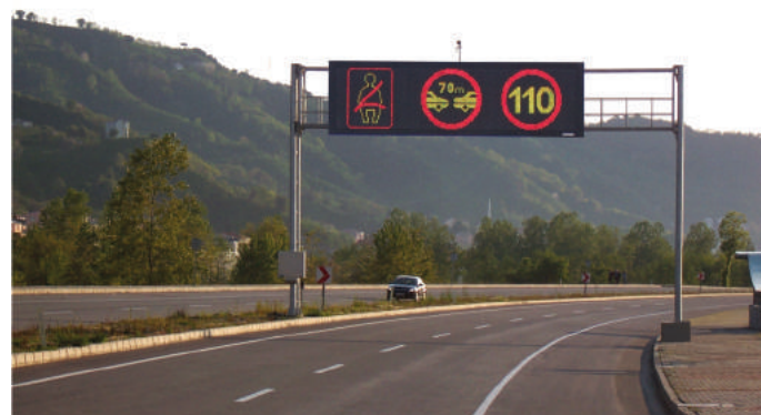
Blacksea Coast Road, Espiye Sarp Tunnelleri, VMS, TRABZON / 2009 Karadeniz Sahil Yolu, Espiye Sarp Tünelleri, VMS, TRABZON
