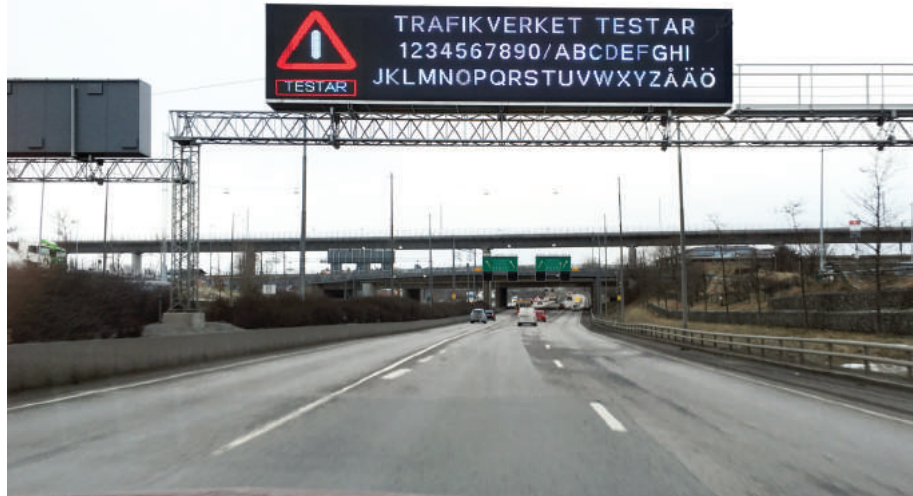
E4 E20 Varby Bridge, WALK-IN VMS, SWEDEN / 2015 E4 E20 Varby Köprüsü, KABİNLİ VMS, İSVEÇ
