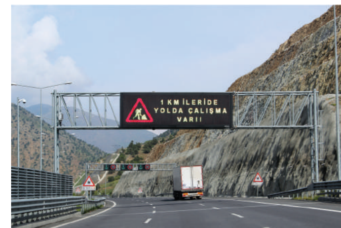
Pozantı Eminlik Tunnels ITS, ADANA / 2010 Pozantı Eminlik Tünelleri AUS Projesi, ADANA
